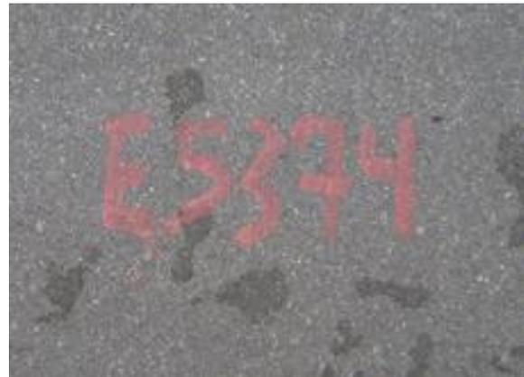
Figura 5 – Marcação de estacas do Projeto Geométrico na faixa de domínio. Foto: Acervo LA/UFPE.
